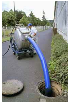
Gabenlose Sanierung mit Inliner
