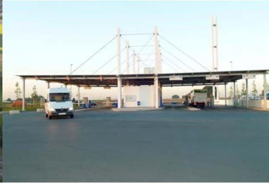
Pförtneranlage FZ Frankfurt
