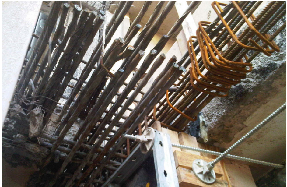
Bewehrungsanschluss Bestand an Neues Treppenhaus
