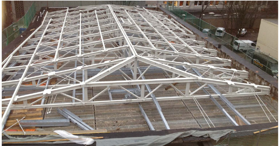
Neue Dachkonstruktion am 12.01.2012
