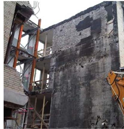
Dies liegt zum einen an der sehr komplizierten statischen Anbindung der neu zu erstellenden Tragkonstruktion des Treppenhauses an die vorhandenen Baustrukturen (siehe z. B. nachstehendes Foto)
