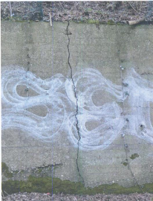
Abb.3: Betonkorrosion an der Stützmauer des Kalkberges
