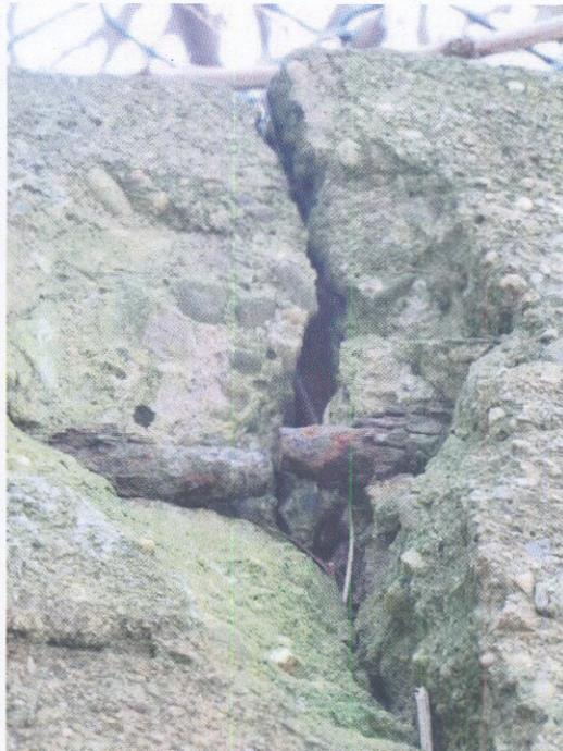
Abb.2: Stark korrodiertes und durch den Bergdruck des Kalkberges geborstenes Moniereisen in Nahaufnahme
