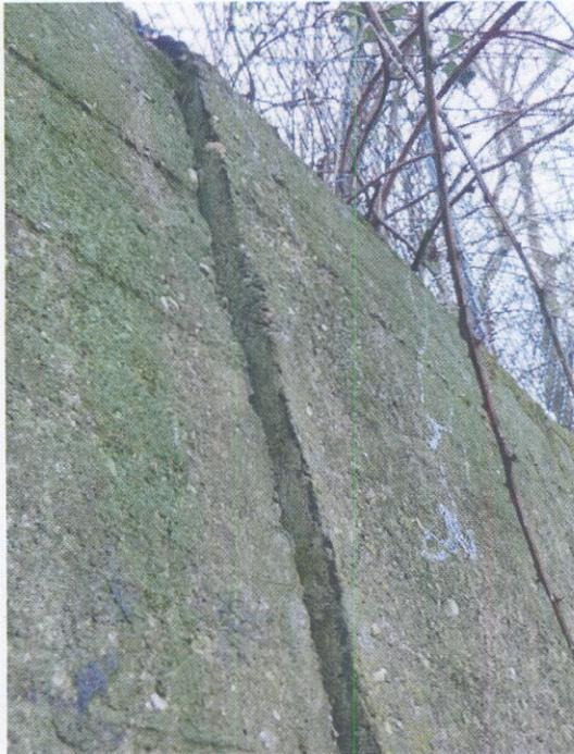
Abb.4: Dieser Versatz eines Teilstücks der Stützmauer wurde vermutlich durch den Bergdruck des Kalkberges verursacht
