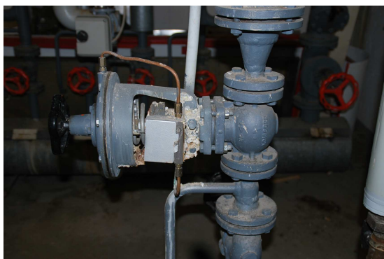
Abbildung eines notwendigen Schiebers der Heizungsanlage
