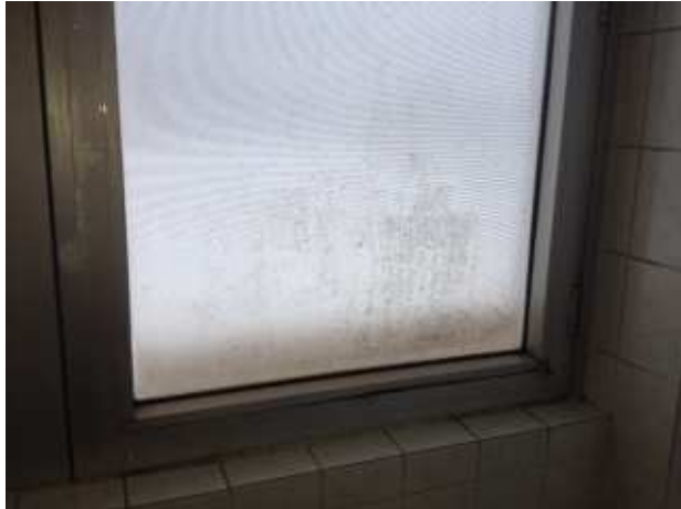
Abbildungen der Fassade Bauteil A und Fenster
