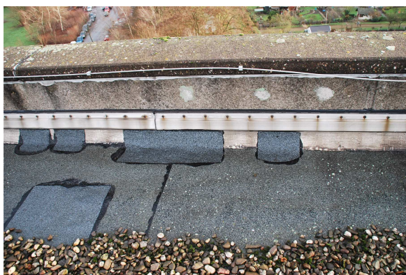
Abbildung des Daches Bauteil A
