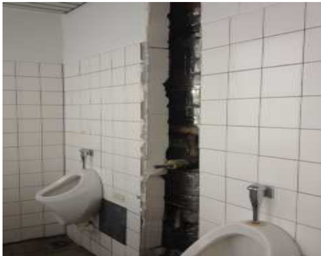
Abbildung einer Toilettenanlage im 3. Obergeschoss Bauteil A
