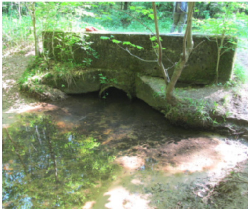
Foto Ist-Zustand (M5), Auslaufbereich des Durchlasses
