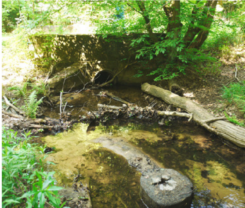
Foto Ist-Zustand (M5), Auslaufbereich des Durchlasses
