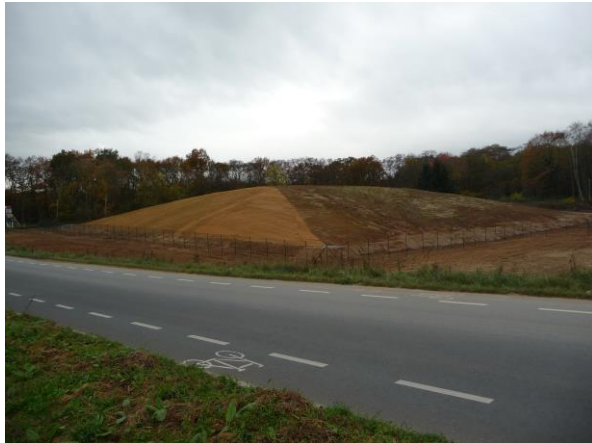
Sicherungsbauwerk, Sicht Richtung Westen
