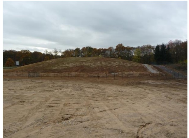
Sicherungsbauwerk, Sicht Richtung Süden
