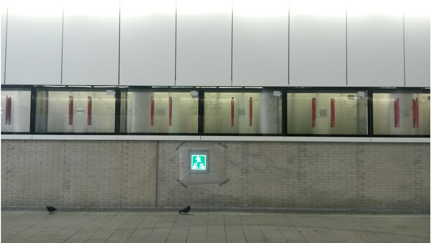
Display-Gehäuse in der Tunnelwand
