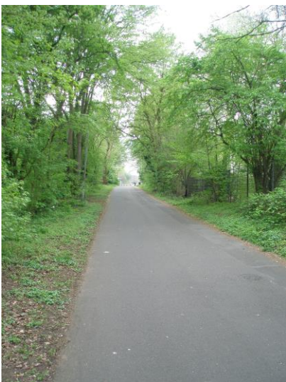
Blick Richtung Arnsberger Straße
