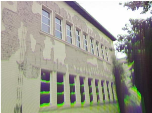
Nach der letzten Sanierung ist auf der Wetterseite (Rheinseite) der Außenputz abgefallen. Seit Jahren sind das Mauerwerk und eine Betonfüllung nicht gegen die Witterung geschützt. Die Stahlarmierung liegt offen und rostet. Seit 2010 ist diese Sanierung vorgesehen, aber immer noch nicht durchgeführt. Dieses Nichthandeln der Gebäudewirtschaft führt zu einem wirtschaftlichen Schaden für die Stadt, da das Gebäude dem Verfall ausgesetzt wird. Weiterhin wird dringend benötigter
