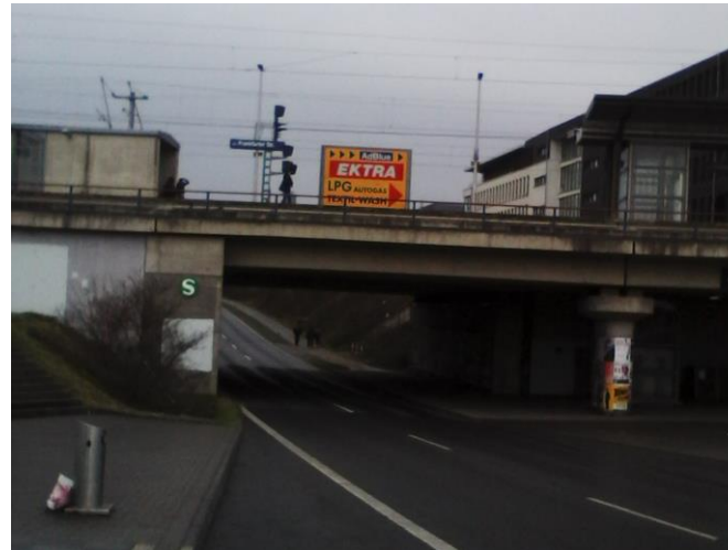
S – Bahnhof Frankfurter Straße, Gremberghoven, ÖPNV – Spur durch Brücke verbaut.
