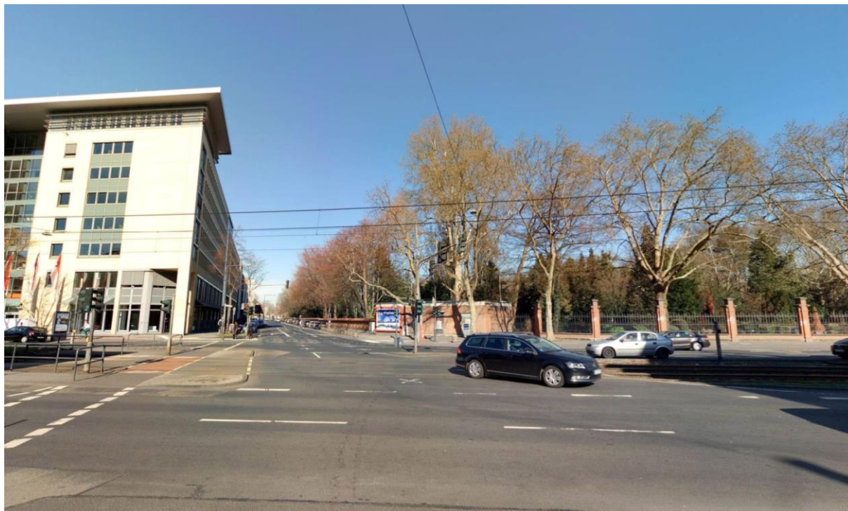
Kreuzung Aachener Straße/Oskar-Jäger-Straße keine gesicherte Querung für den Radverkehr im Knotenpunkt in Richtung Norden Oskar-Jäger-Straße entlang des Melatenfriedhofes in beiden Richtungen keine Radverkehrsführung
