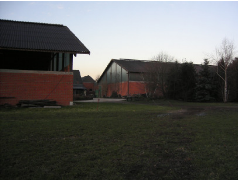
Ansicht links Halle gegenüber der Anpflanzung, im Hintergrund Reithalle und rechts die Anpflanzung
